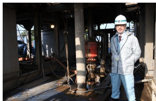
写真-5 掘削現場で立会する筆者
