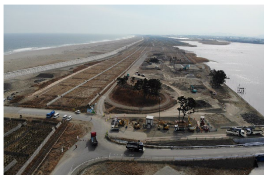
写真-6 造成中の名取市サイクルスポーツセンター
