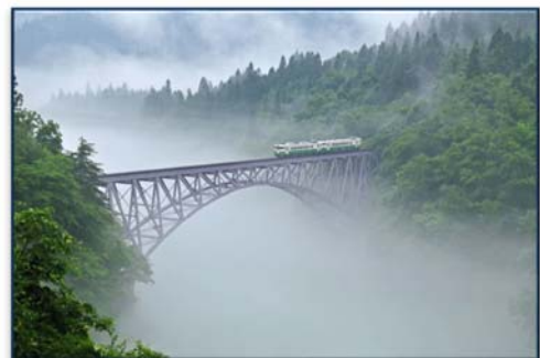
第一只見川橋梁
