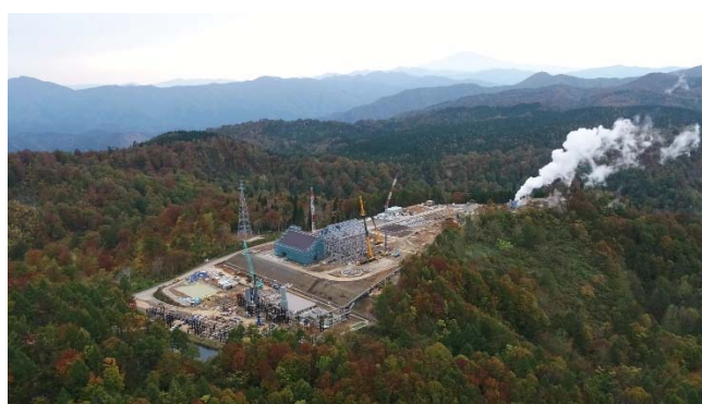
【山葵沢地熱発電所（建設中）】
