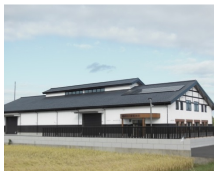
H25 竣工：防災備蓄倉庫
