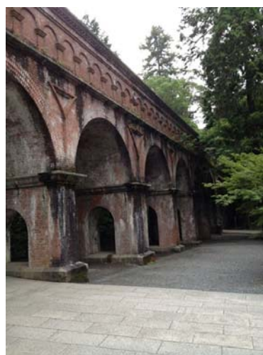
写真-1 京都市 南禅寺内の水路閣
