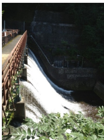
写真-2 仙台市 青下第一ダム
